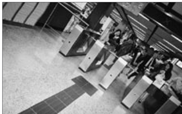
Tunnelbana med taktil markering
